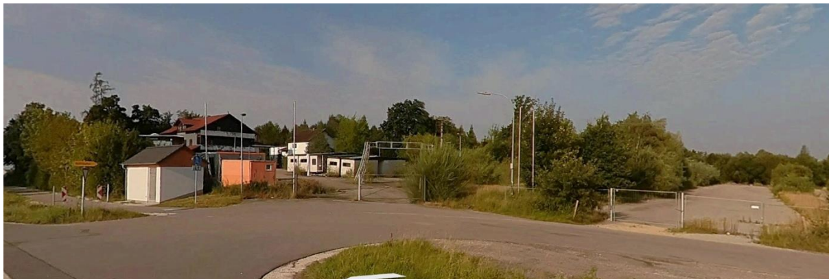
Bestandsgebäude im Geltungsbereich mit vorhandener verdichteter Parkplatzanlage (Blick von Nordosten)
