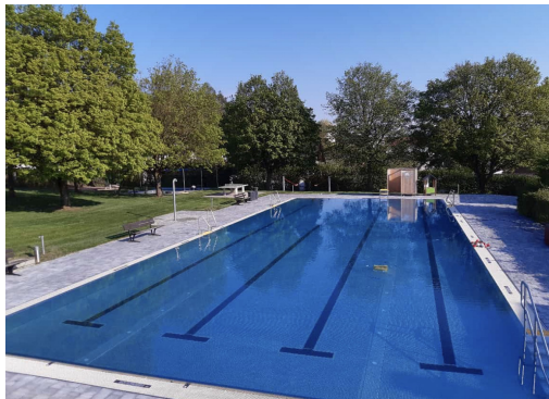
Das neue Becken im Freibad Jellenkofen
