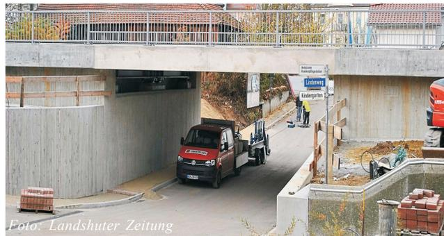
Der Brückendurchgang wurde auf neun Meter erweitert, so erhielten die Gehwege rechts und links jeweils 1,5 Meter Breite. Die Durchfahrtshöhe der Eisenbahnbrücke blieb bei 3,65 Meter. Die Gesamtkosten der Erneuerung der Eisenbahnbrücke mit Unterführung betragen rund 3,5 Millionen Euro. An den Kosten für die Straßensanierung und Gehwegverbreiterung ist die Marktgemeinde
